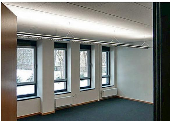
Blick in eines der automatisierten Büros mit Beleuchtungssteuerung (Tageslicht/Präsenz), Sonnenschutz und Einzelraumregelung (ERR).
