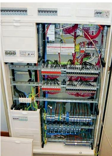
Etagen-Elektroverteiler mit KNXnet IP-Controller und weiteren Geräten.
