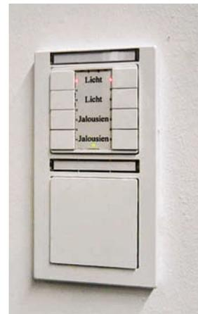
KNX-Geräte wie Taster oder Präsenzmelder kommunizieren über die Standard KNX-Busleitung mit dem Automatisierungssystem.
