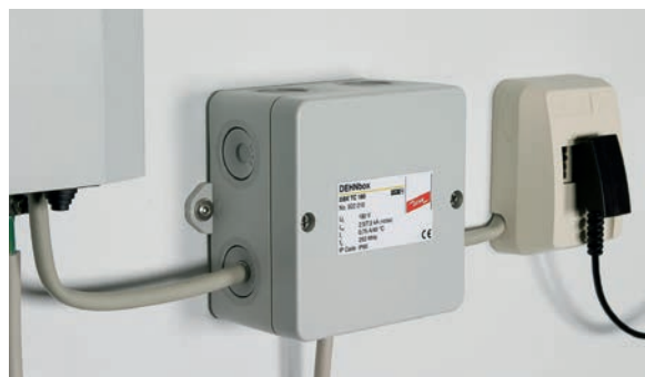
DEHNbox schützt den Telekommunikationsanschluss und DSL
