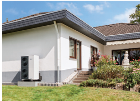
Im Jahr 2020 wurden 120.000 Heizungs-Wärmepumpen installiert – 40 Prozent mehr als im Vorjahr.
