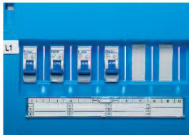
Gleichzeitig werden Leitungsschutzschalter in der richtigen Position zur Berührungsschutzplatte positioniert.
