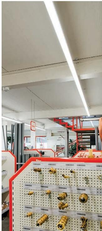
Die Montage ist über einen neuen Druckverschluss werkzeuglos schnell und sicher erledigt. Die IP20-Ausführung gibt es mit fixen Kontakten für ein durchgängiges Lichtband oder mit variablen Kontakten, wenn anwendungsbezogene Unterbrechungen gewünscht sind.
