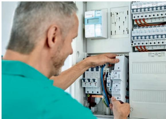
Der neue Kombibleiter FLASHTRAB FLT-SEC-ZP spart bei der Montage Platz durch die schmale Baubreite von 47 Millimetern – und Zeit durch werkzeuglose Montage. Der praktische Fußriegel ermöglicht die automatische Verrastung auf allen Sammelschienendicken.
