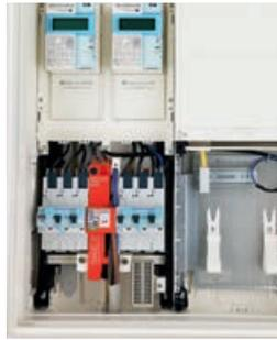
Der Kombi-Ableiter ist schmal, passt dazwischen, ist werkzeuglos montiert und die Energieversorgung für SMG sowie APZ ist auch integriert.
