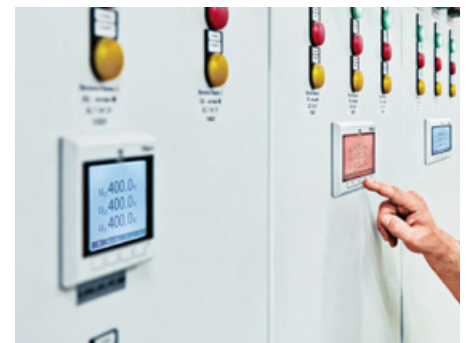
Smart: Bei Fehlern wechselt die Hintergrundbeleuchtung der EMpro-Energiemessgeräte auf rot.
