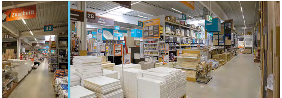
Der OBI-Markt in Haßfurt: Links vor der Beleuchtungssanierung, rechts danach.
